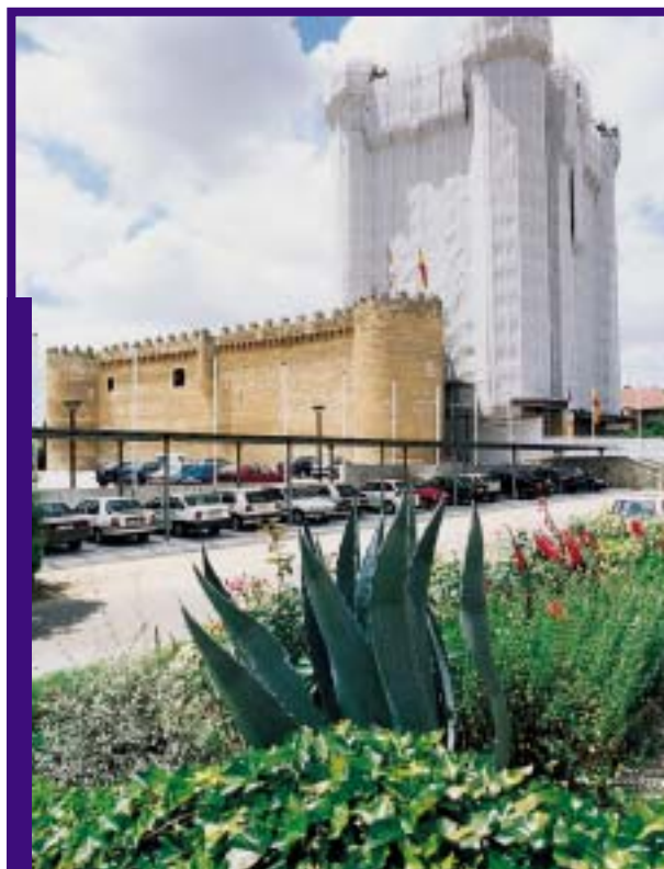
Obras de Consolidación del Castillo de Fuensaldaña, sede provisional de las Cortes de Castilla y León
