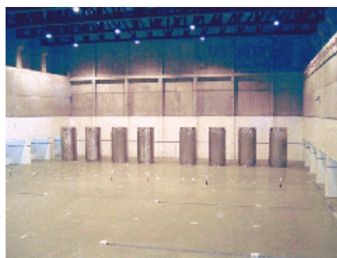
FIGURA 7. ALMACÉN C.N. TRILLO (Finales 2005)
