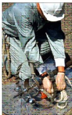
Retirada Cabezal Pararrayos Radiactivo
